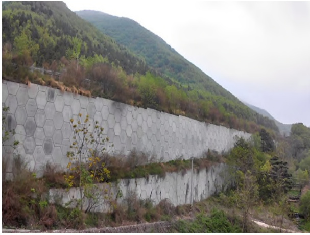
3공구 패널식 옹벽 01
