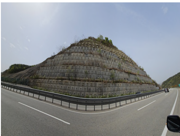
4공구 패널식 옹벽 05
