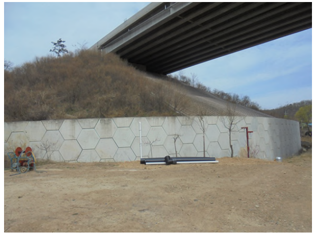
8공구 패널식 옹벽 14
