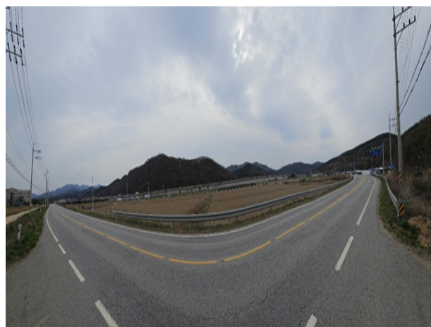
6공구 패널식 옹벽 08
