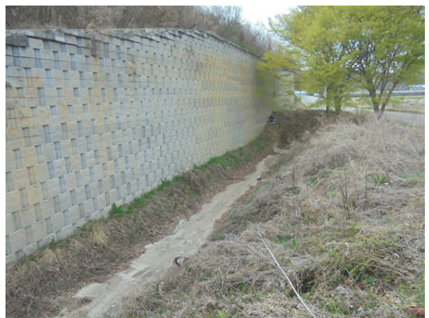
5공구 블럭식 옹벽 06
