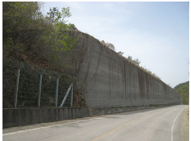
4공구 블럭식 옹벽 04
