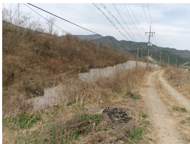
7공구 패널식 옹벽 11
