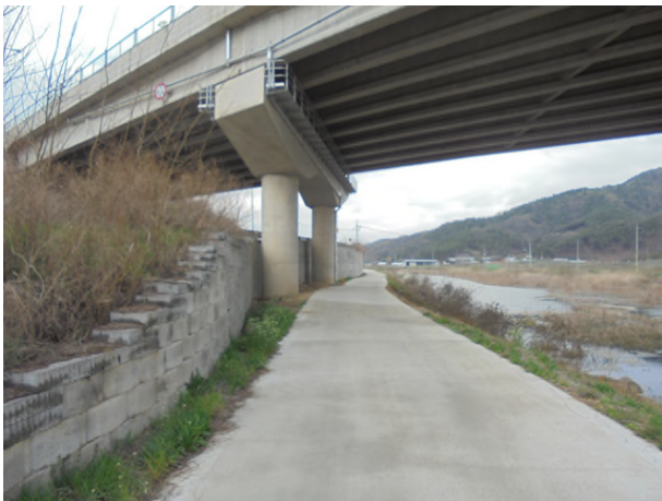
3공구 블럭식 옹벽 03
