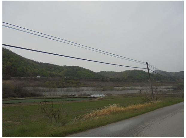
3공구 패널식 옹벽 02
