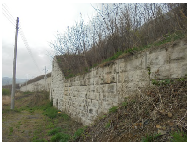
6공구 패널식 옹벽 07
